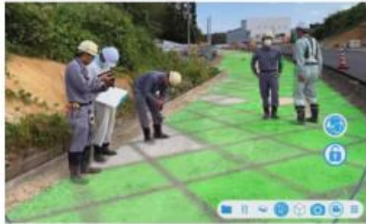
ARを活用した土工の出来形確認
