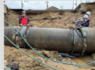
＜地震による送水管の損傷＞
