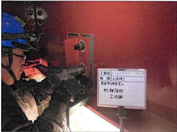
アンカーボルト削孔位置 削孔平均位置
