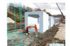
掘削作業時にARと比較
